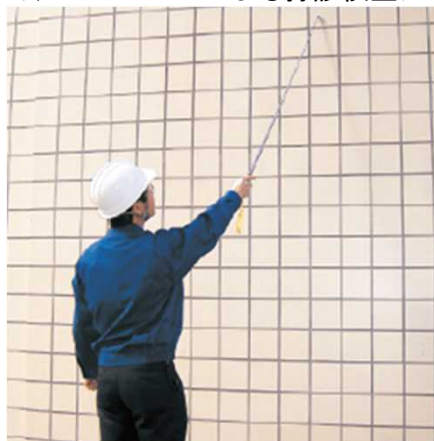
<テストハンマーによる打診検査>
