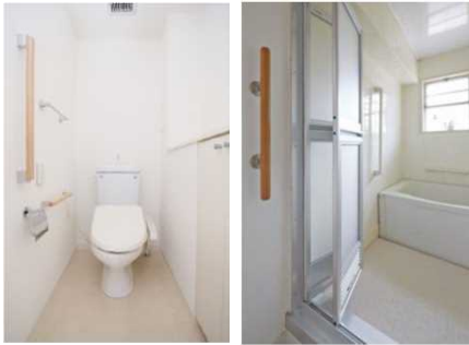
住戸内への手すりの設置
