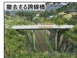
撤去する跨線橋 老朽化が進んだ跨線橋を撤去し隣接橋へ機能を集約
