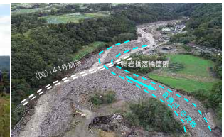
国道144号（群馬県嬬恋村）鳴岩橋 ※大規模災害復興法に基づく国による権限代行
