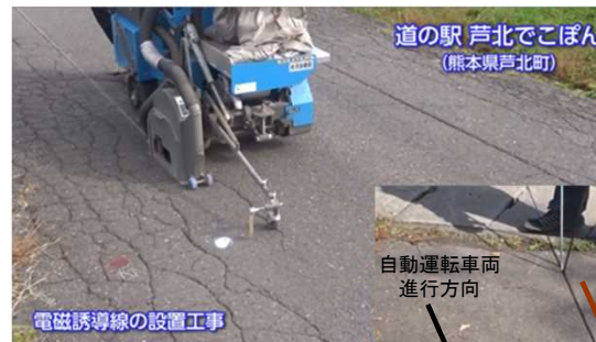
敷設のための舗装切断
