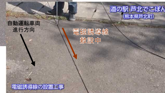
路面切断後の電磁誘導線敷設状況
