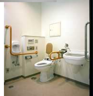
多様な利用者に配慮した多機能トイレの整備
