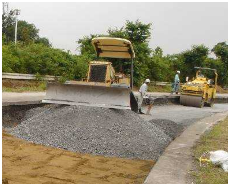
道路路盤材としての使用
