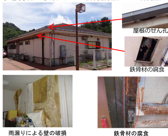
○老朽化の状況 (H27. 2老朽度調査、H29. 3再調査)
