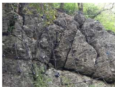
落石防護網の設置や落石の除去
