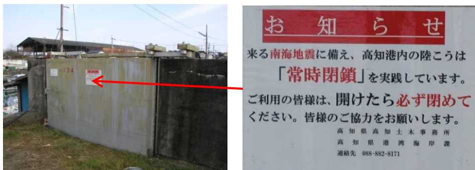
利用度の低い陸閘を常時閉鎖
