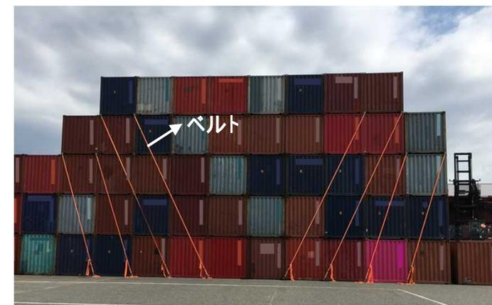
ベルトによる空コンテナの固縛の状況
