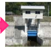
堤防整備、排水機能の強化に併せて樋門を1箇所に集約(集約の事例)
