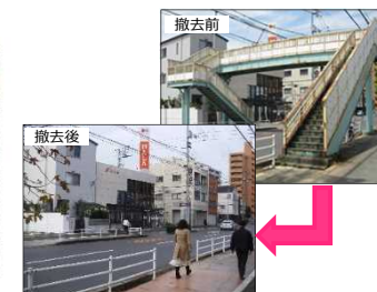
バリアフリーな歩道空間確保のため老朽化した横断歩道橋を撤去(廃止の事例)
