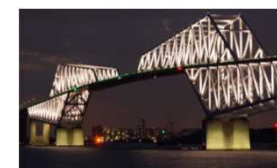
橋梁に搭載されたセンサーによる異常変異の早期発見(高度化・効率化の事例)
