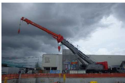
ラフタークレーンによる施工
