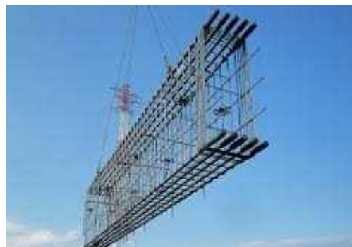
梁鉄筋地組取付
