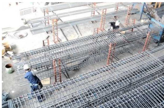
梁鉄筋工場地組
