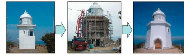
補強前 補強後 鉄筋コンクリートを用い建物及び基礎の補強を実施 灯台の耐震補強工事
