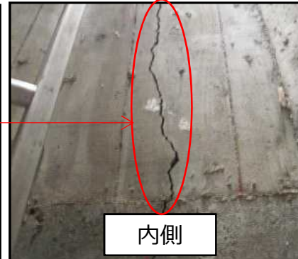
〔灯塔亀裂（貫通状態）〕
