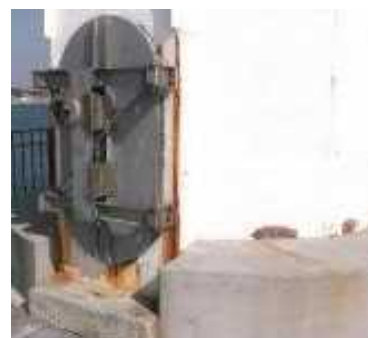
〔灯台（外部、上部、基礎部）の発錆状況〕
