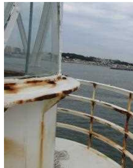
〔灯台（外部、上部、基礎部）の発錆状況〕
