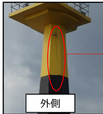
〔灯塔亀裂（貫通状態）〕
