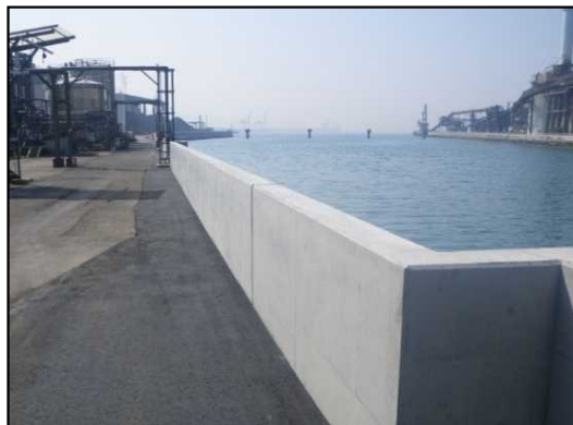
【護岸嵩上げ後】
