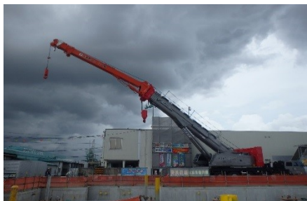
ラフタークレーンによる施工
