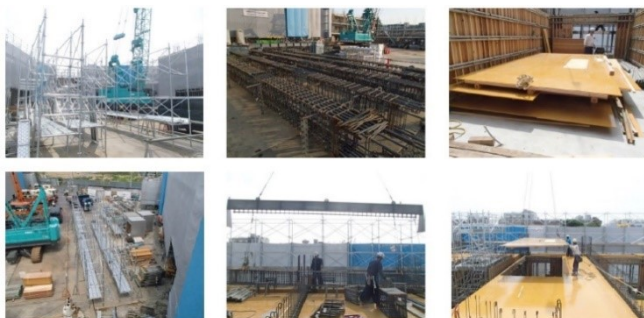
地組(足場・型枠・鉄筋)のイメージ
