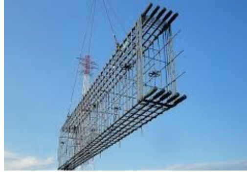
梁鉄筋地組取付
