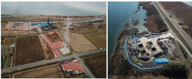
ドローン画像による現場状況確認
