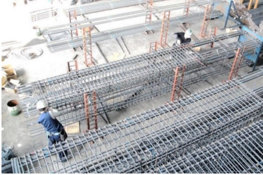
梁鉄筋工場地組
