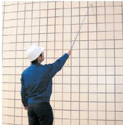
<テストハンマーによる打診検査>
