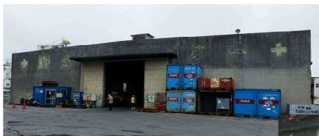
1号上屋 (RC造屋根S造) 経過年数：60年 敷地面積：2,700m 2
