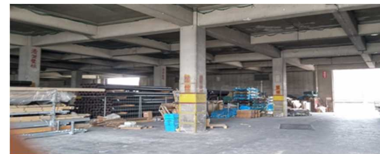
＜整備前の上屋利用状況＞
