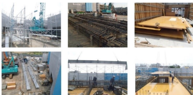
地組(足場・型枠・鉄筋)のイメージ
