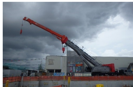
ラフタークレーンによる施工
