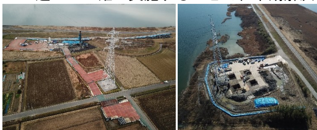
ドローン画像による現場状況確認
