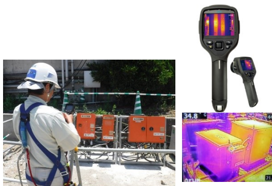
サーモグラフィーの活用
