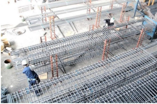
梁鉄筋工場地組
