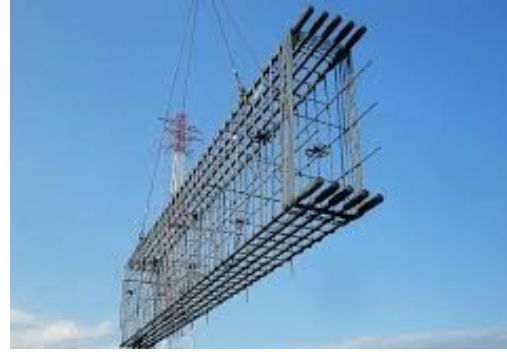
梁鉄筋地組取付
