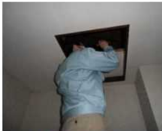
「小屋組・梁」調査の様子
