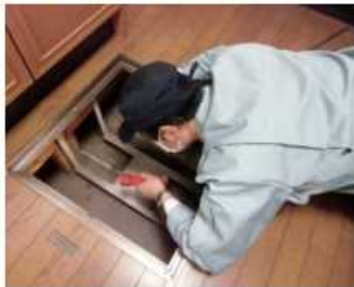
「土台・床組、基礎」調査の様子
