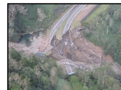
国道274号 日勝峠8号目付近盛土崩壊（清水町）
