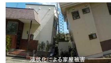
液状化による家屋被害
