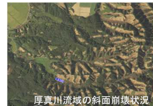
厚真川流域の斜面崩壊状況
