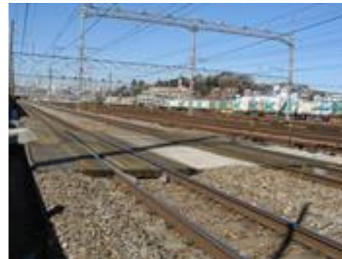
工事用重機械の搬入通路
