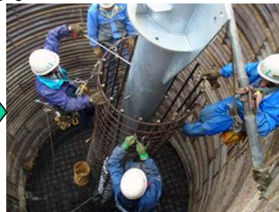
脚材の据付・配筋
