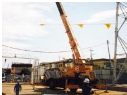
移動式クレーン
