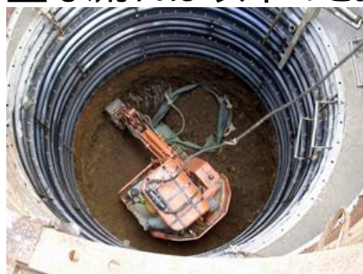
基礎孔の掘削
