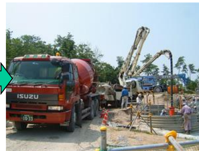
コンクリート打設
