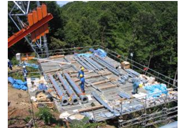
作業構台の設置
