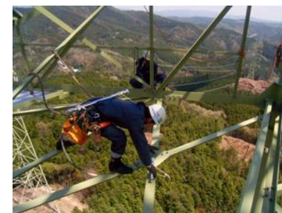
ボルトの締め付け
