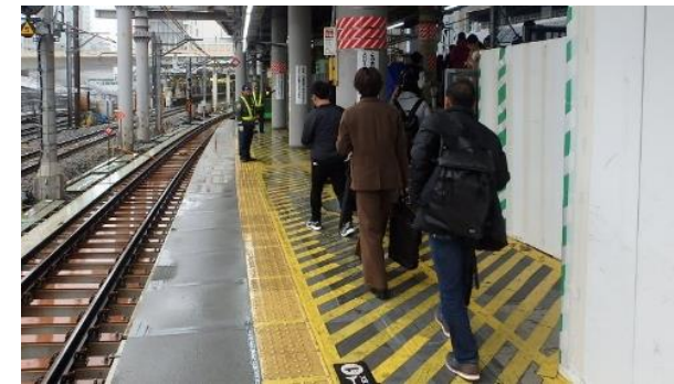
駅構内工事でのお客さまへの安全配慮
