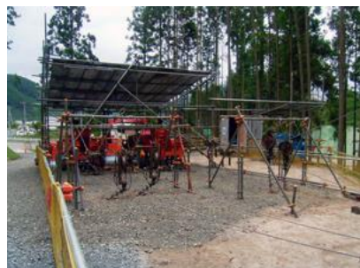
エンジン場（電線を引っ張る）
