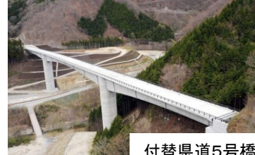
付替県道5号橋
