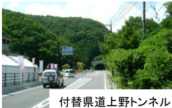
付替県道上野トンネル
