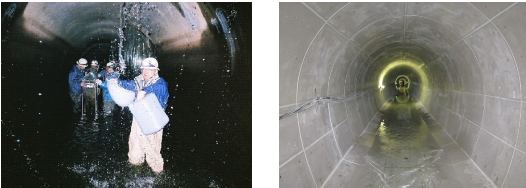
図 43 群馬用水緊急改築事業（左：地下水の侵入、右：内巻き補強施工完了）
