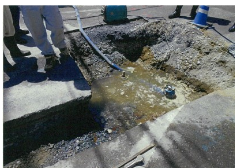
図 63 漏水状況（千葉県工業用水道）
