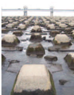
下流護床工の改修
