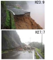
【写真】国道168号崩壊状況
