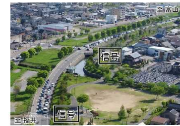
写真3 海側幹線側道部の状況
