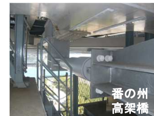
制震ダンパー設置
