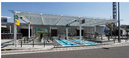
身体障害者駐車マス整備(淡路SA)
