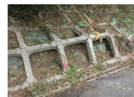
3ヶ年緊急対策箇所の法面对策
