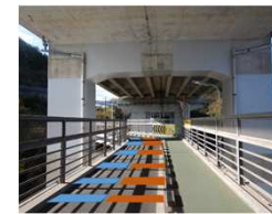
因島大橋 (施工イメージ)
