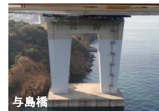
橋脚繊維巻き立て
