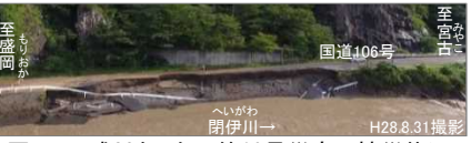
図4 平成28年 台風第10号災害の被災状況
