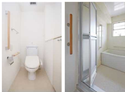
住戸内への手すりの設置
