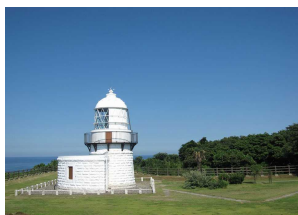
【能登】 緑剛埼灯台 (半島先端部)
