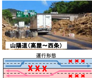
<片側一車線での物資輸送車両の通行状況>
