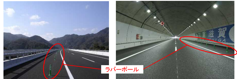
現況写真(構造物6車線対応区間)
