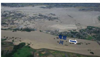
① 鬼怒川の堤防決壊による浸水被害 (茨城県常総市)
