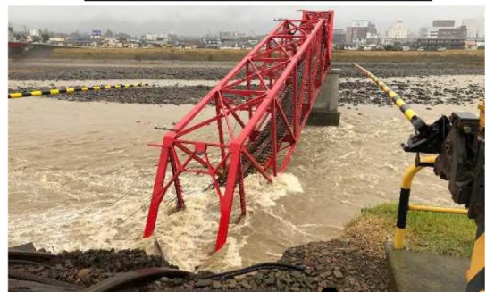
上田電鉄別所線(千曲川橋梁)
