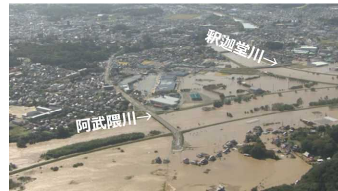
阿武隈川浸水状況（福島県須賀川市他）
