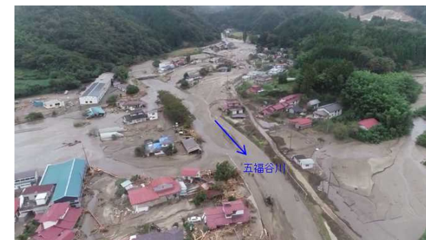
土砂・洪水氾濫発生委状況（宮城県丸森町）
