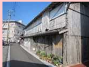
空き家の除却
