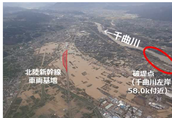
信濃川水系千曲川浸水状況（長野県長野市）
