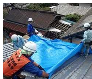
ブルーシートの設置状況（芝山町）
