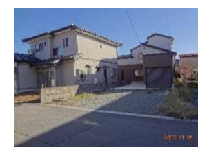
【空き地B】住宅建設後
