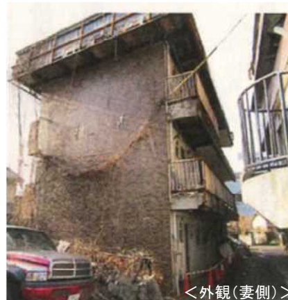
外壁、手すりが崩落した事例
