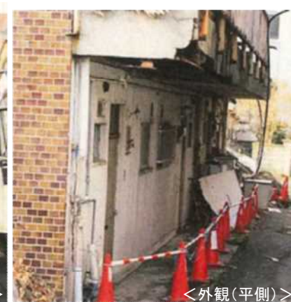
外壁、手すりが崩落した事例
