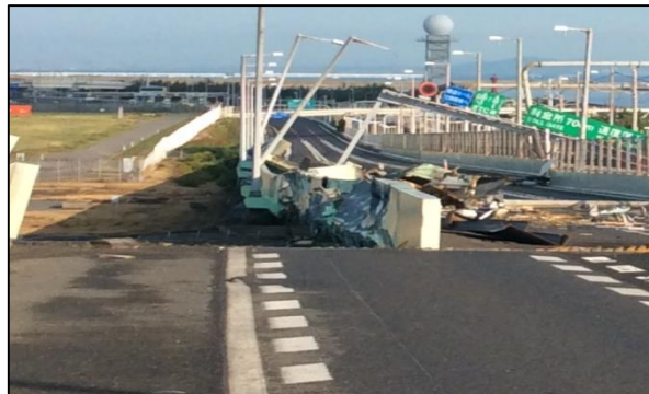
・強風によりタンカーが関空連絡橋に衝突し損傷
