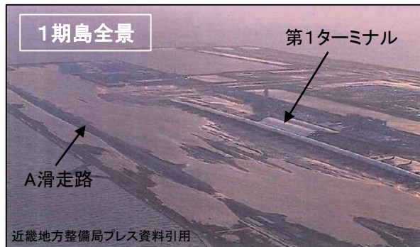
・高潮による旅客ターミナル・滑走路の浸水被害
