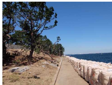
護岸応急復旧状況 (9月19日撮影)
