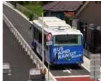
ひたちBRTの事例(茨城県日立市)
