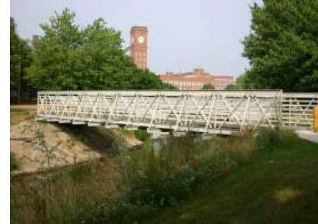
米国のFRP歩道橋の例 (FRP: 繊維強化プラスチック)
