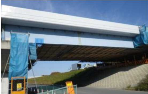
橋梁点検と補修工事で足場を共有
