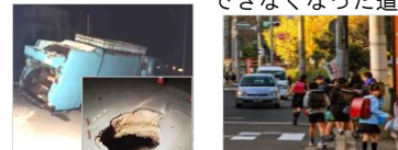
下水道の老朽化による道路陥没 電柱により通学児童が車道にはみ出す
