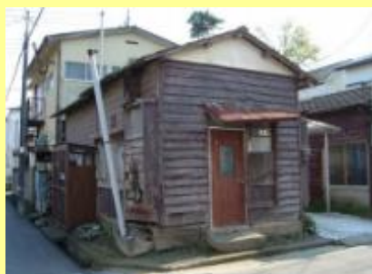
分譲当初のままの平屋建て住宅(空き家)
