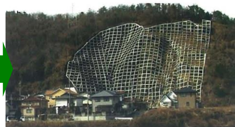
法枠工 (施工後)
