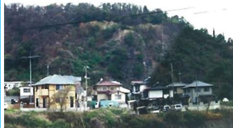
法枠工 (施工前)
