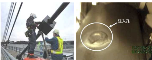
(例) 自走式ロボで斜材表面を撮影
