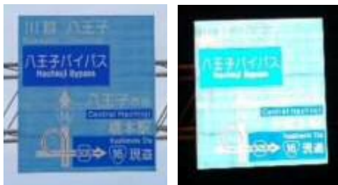
「かすれ(左)」や「夜間の視認性低下(右)」により見えづらい標識 全標協資料より
