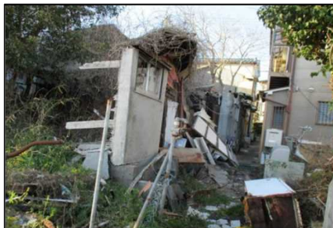
瓦礫が放置され、雑草の繁茂や不法投棄も発生している管理不全状態の土地
