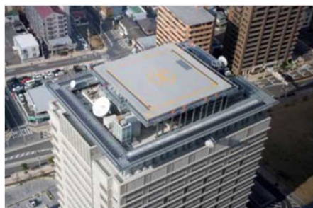
屋上ヘリポート
