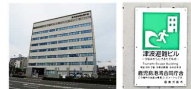
(鹿児島港湾合同庁舎)津波避難ビルの機能を確保
