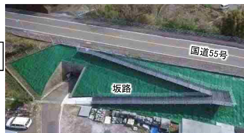
想定した浸水深よりも高い歩道部への坂路を整備 (国道55号 高知県安芸郡奈半利町)
