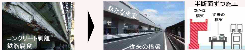
構造物全体の架け替えを実施
