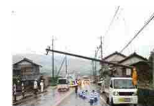
沿道の電柱の倒壊による道路閉塞
