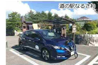
道の駅でのEV充電施設の設置
