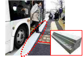
〔隙間を空けずに停留所に停車可能な縁石〕
