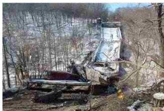
ファン・ホロ-橋崩落（2022年） （国家運輸安全委員会（NTSB）HPより）
