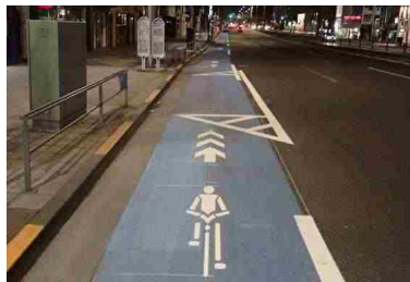
(国道246号:青山地区)
