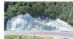
法面吹付工、落石防止網工
