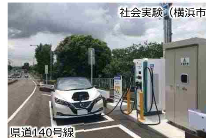
公道でのEV充電施設の設置
