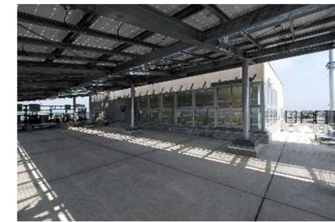
屋上津波避難スペース併設
