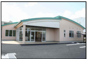
防災力強化の取組 (避難所の整備・改修等)
