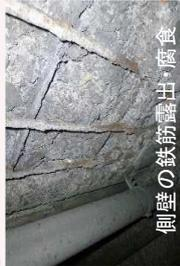
側壁の鉄筋露出・腐食
