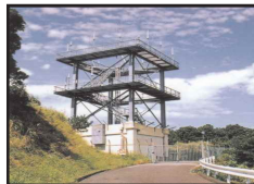
遠隔対空通信施設
