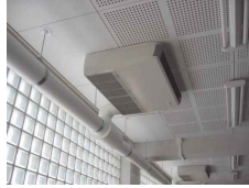
学校等の防音工事(防音サッシ・空調機)
