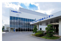
老朽化の進む千葉療護センター(築38年)
