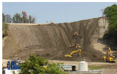
盛土撤去工事のイメージ
