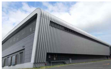
データセンター
